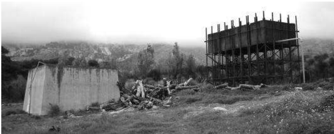
Το τέρμα της οδού Μεσολογγίου στην Παλαιά Πεντέλη. Εδώ βρίσκεται, σύμφωνα με την ιστοσελίδα του δήμου Πεντέλης, η είσοδος του Αδριάνειου υδραγωγείου. (Φωτ. ΟΡΕΣΙΒΙΟΣ)
