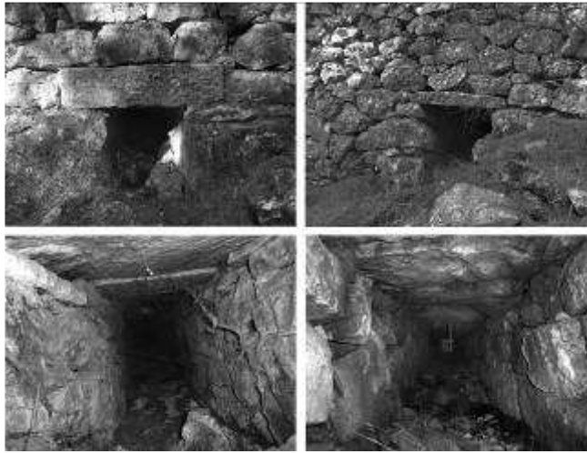
Οι αγωγοί των υδάτων (Φωτ. ΟΡΕΣΙΒΙΟΣ)
