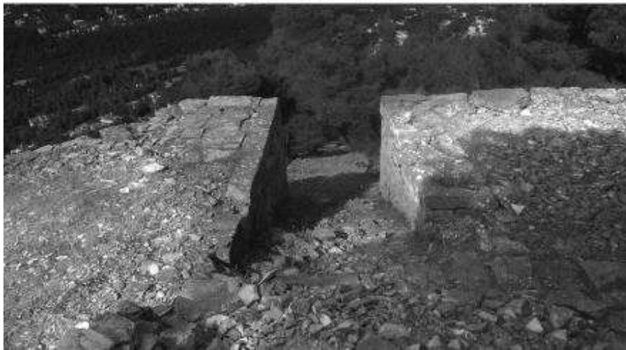
Το άνω τμήμα της καταράκτας (Φωτ. ΟΡΕΣΙΒΙΟΣ)
