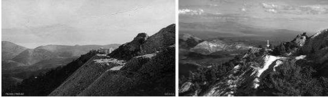
Αρ. Τα ερείπια των εγκαταστάσεων όπως ήταν έως το 1943-44. (Φωτ. Ε.Ο.Ο.Α, παραχωρήθηκε από Νίκο Νέζη. Δεξ. φωτ. Το ίδιο σημείο (με βελάκι) σήμερα. (Φωτ. Δρόσος Δρόλαπας)
