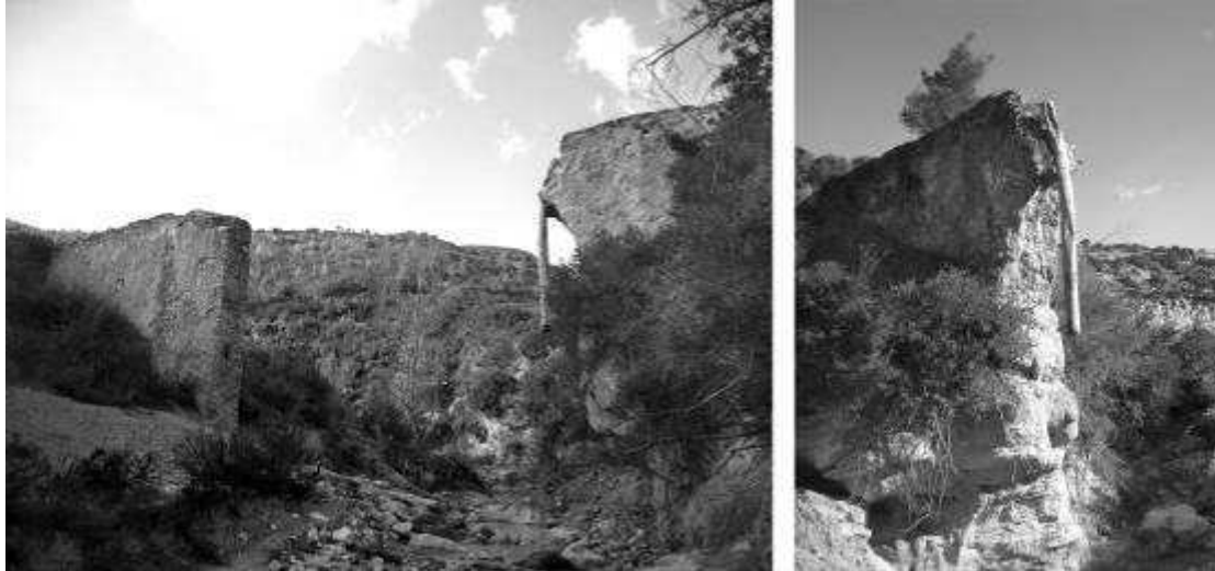
Το υδραγωγείο του Διονύσου. (Φωτ. ΟΡΕΣΙΒΙΟΣ)
