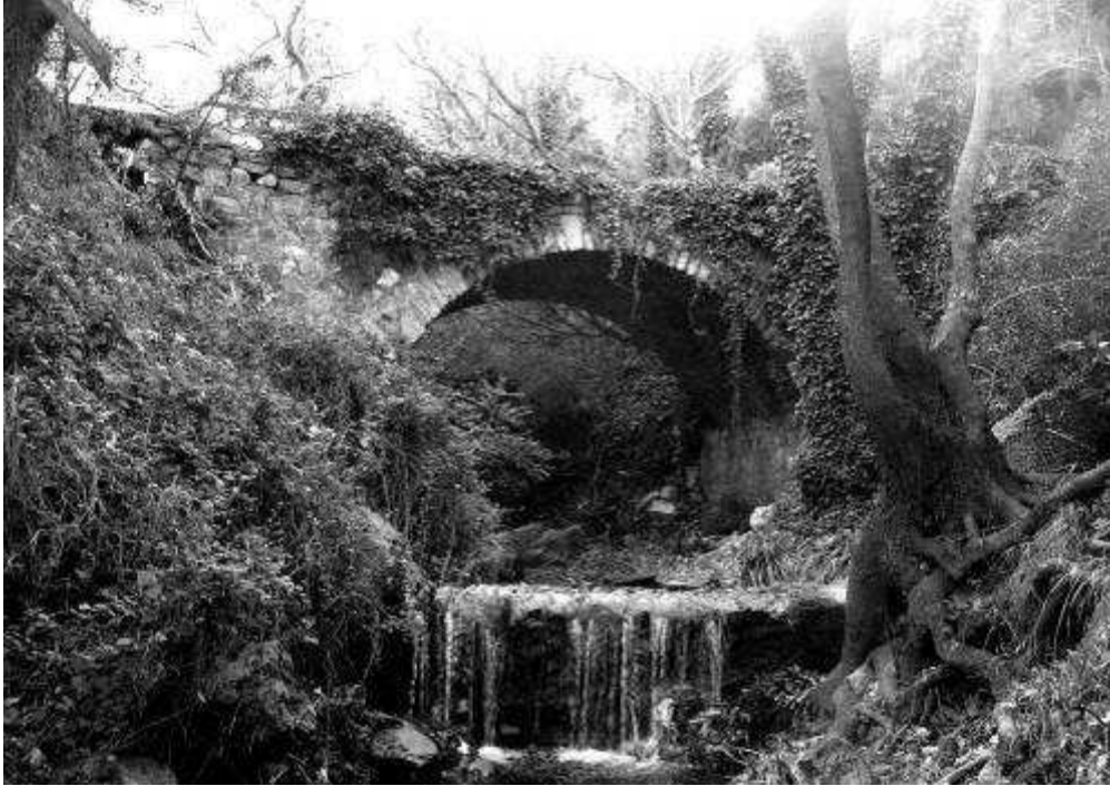
Η μικρή γέφυρα. (Φωτ. ΟΡΕΣΙΒΙΟΣ)
