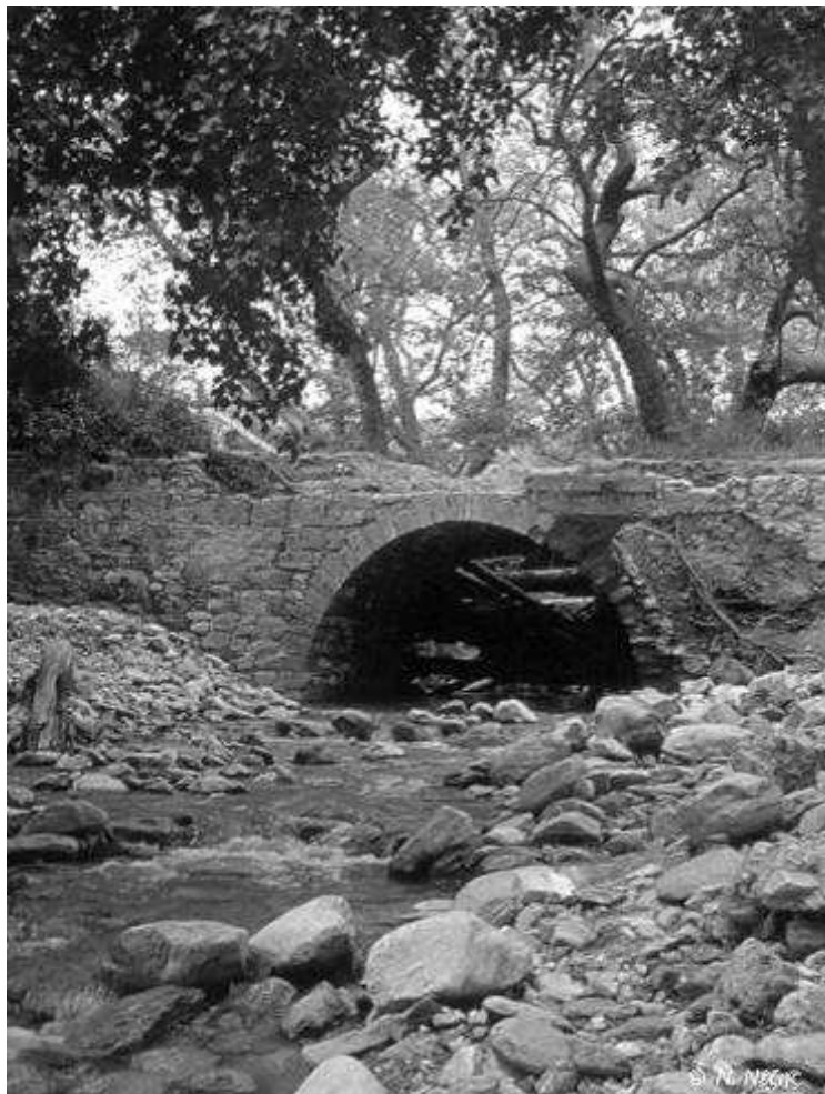
Η γέφυρα στο Ντράφι πριν μισογκρεμιστεί. (Φωτ. Νίκος Νέζης)
