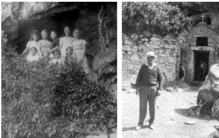
Εκδρομείς και λατόμοι έξω από τη Σπηλιά. (Φωτ. από www.nea-penteli.gr )
