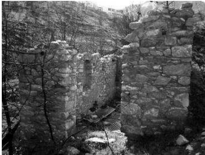
Το μεγάλο κτίσμα στην κοίτη της ρεματιάς. (Φωτ. ΟΡΕΣΙΒΙΟΣ)
