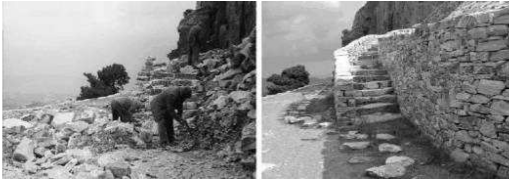
Στιγμιότυπα από την κατασκευή της μεγάλης σκάλας. (Οι φωτ. παρατίθενται από Ηλία Αποστολίδη, βλ. σημ. 1)
