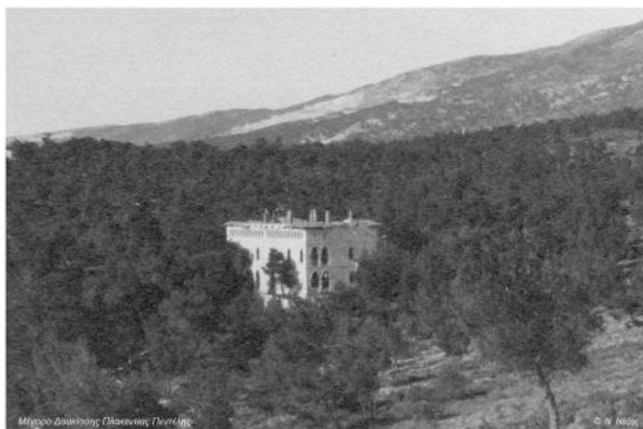
Το Καστέλο της Ροδοδάφνης χωμένο μέσα στο απέραντο δάσος. (Φωτ. Πλάτωνας Μεταξάς. Παραχωρήθηκε από Νίκο Νέζη)
