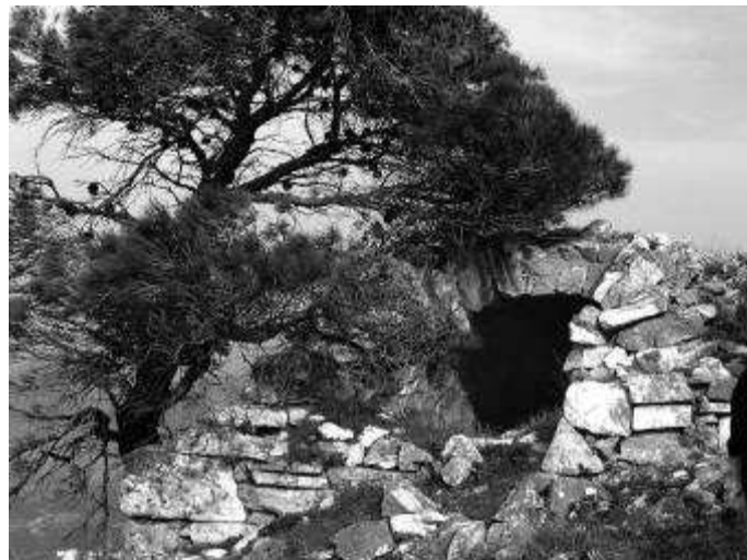
Η δεξαμενή με την αγιδωτή οροφή. (Φωτ. ΟΡΕΣΙΒΙΟΣ)
