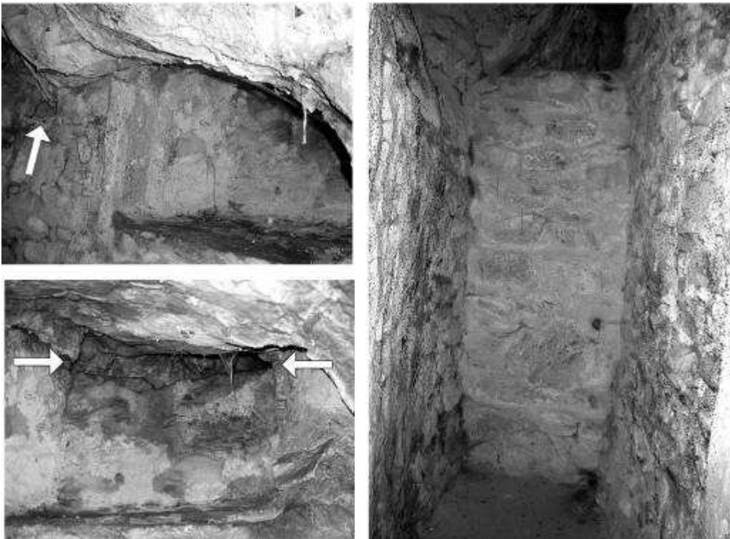
Αρ. πάνω: Η παλιά κόγχη της ιεράς προθέσεως του Ασκητηρίου, ενώ με βέλος σημειώνεται η μικρή οπή. Αρ. κάτω: Με βέλη σημειώνεται το στενό άνοιγμα πάνω από την κόγχη όπου φαίνεται ο «τυφλός» χώρος της Σπηλιάς. 5. Η παλιά δίοδος που ένωνε τα δύο ιερά, και ο διαχωριστικός τοίχος. (Φωτ. ΟΡΕΣΙΒΙΟΣ)
