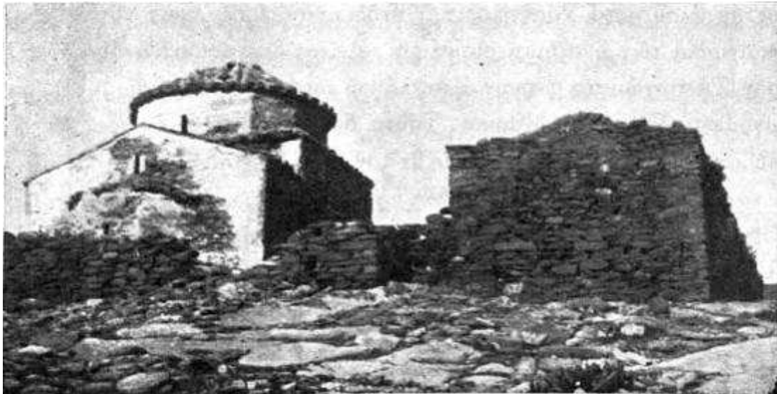
Ο ναός και το ανατολικό ορθογώνιο κτίσμα όπως ήταν το 1933. (Φωτ. Ορλάνδος)
