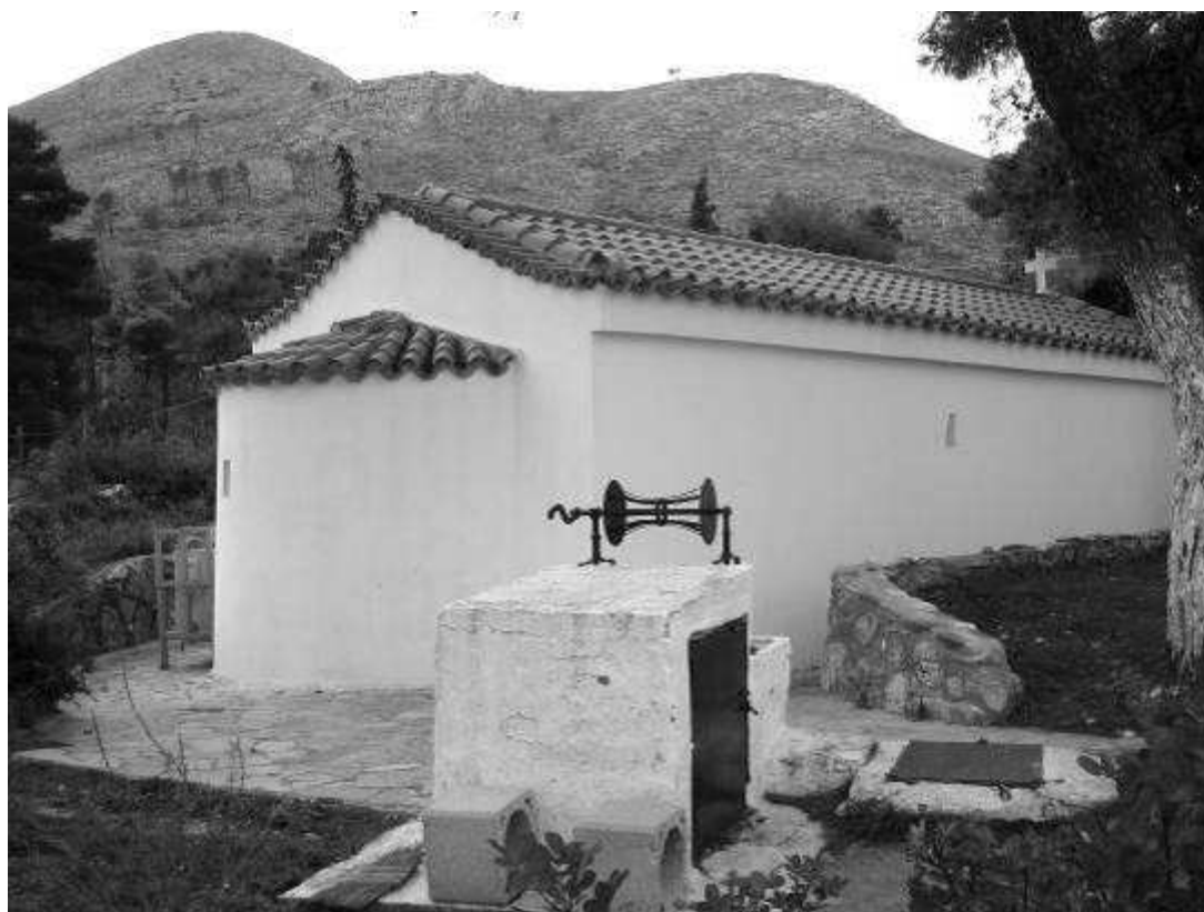
Η ανατολική όψη της εκκλησίας. (Φωτ. ΟΡΕΣΙΒΙΟΣ)
