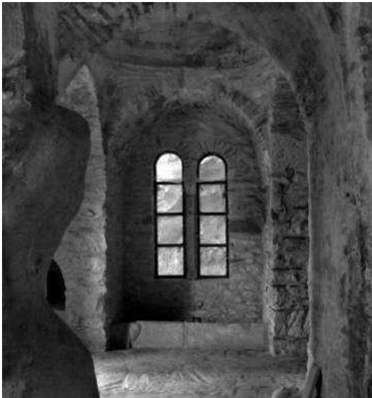
Ο βορεινός τοίχος του Αγ. Νικολάου. (Φωτ. ΟΡΕΣΙΒΙΟΣ)
