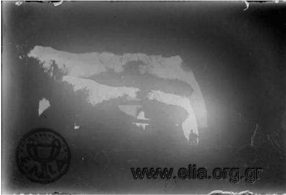
Η μοναδική φωτογραφία του τείχους από το εσωτερικό της Σπηλιάς πριν αυτό γκρεμιστεί. (Φωτ. www.elia.org.gr )
