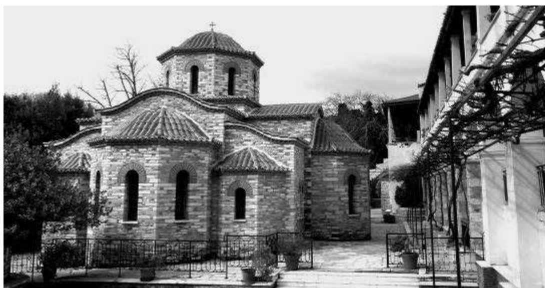
Σε σύγκριση με το σκίτσο είναι ολοφάνερες οι μετατροπές του ναού. (Φωτ. ΟΡΕΣΙΒΙΟΣ)
